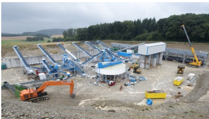
Le site des Délices, à Apples, est le premier gisement de gravier vaudois raccordé à la voie ferrée. FLORIAN CELLA
