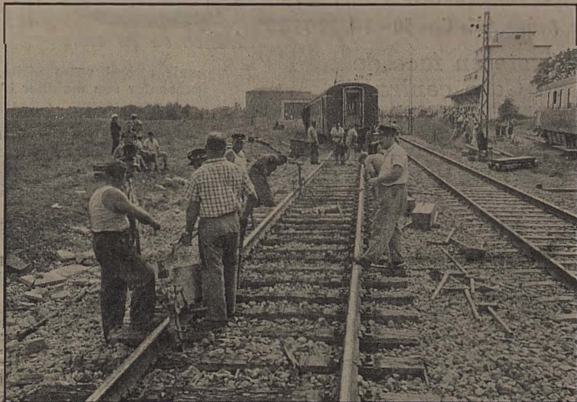
En même temps que se poursuivaient les travaux préparatoires à l'évacuation des wagons, les ouvriers de la voie remettaient en état les rails arrachés lors du déraillement, remplaçant par des pièces neuves celles qui avaient été endommagées et rétablissant les traverses disloquées. (Photos FAL)
