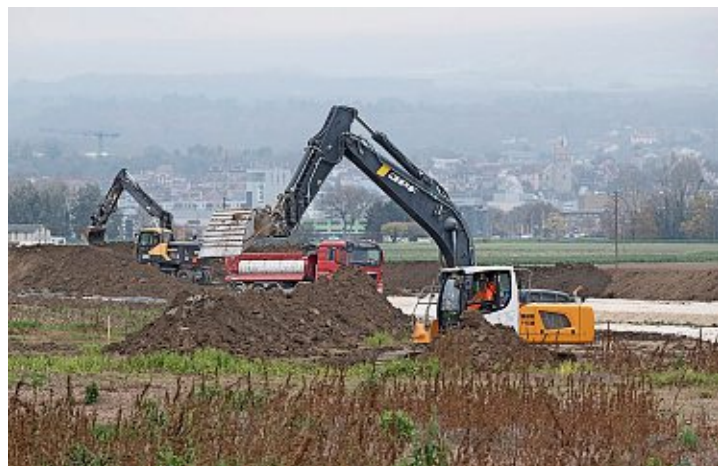
Le chantier de modernisation de la ligne Orbe - Chavornay a démarré officiellement ce lundi 11 novembre. FLORIAN CELLA
