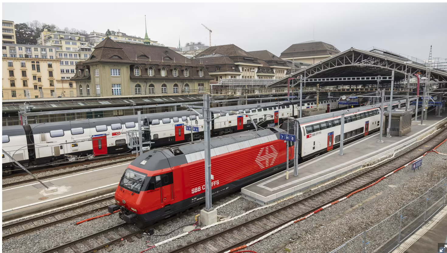
Les travaux avancent progressivement en gare de Lausanne depuis plusieurs mois. 20 janvier 2025. — © CYRIL ZINGARO / keystone-sda.ch
